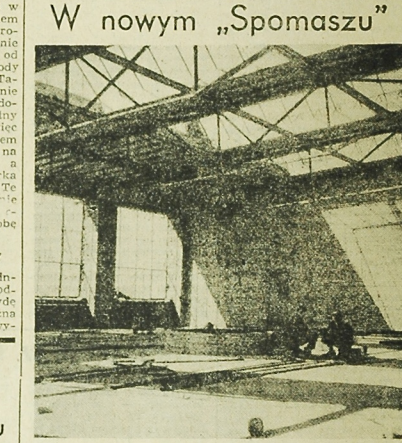
W Starostwie trwa budowa nowego pomieszczenia dla Zakładu Włóczęgo Maszyn i Urządzeń Przemysłu Spółdzielczego. NA ZDJĘCIU: fragment głównej hali produkcyjnej. Fot. w.m
