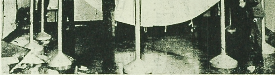
Pierwsze szkolne planetarium w Wielkiej Brytanii zostanie założone w hallu szkoły Wandsworth w Londynie. Planetarium będzie mogło pomóc 40 młodych tropicielaj tajemnic gwiazdnych. Całe urządzenie składa się z ruchomego projektoraz kopuizowanego w 31 sekczech, które może wyświetlać na kopule planetarium około 500 gwiazd. Kopuła jest wykonana z jedwabnej tkaniny i ma średnicę ponad 1 metrów.
