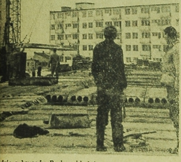
Pracownicy z brygady Bacha układają strop nad pionikami ku. Zaraz po nich przyjdzie tu brygada Radziszewskiego.
