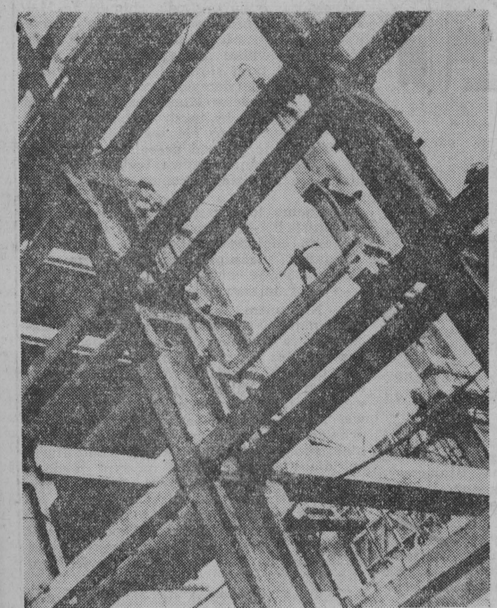
Montaż Bielojarskiej Elektrowni Atomowej na Uralu Foto: J. Korolow (ZSAR)
