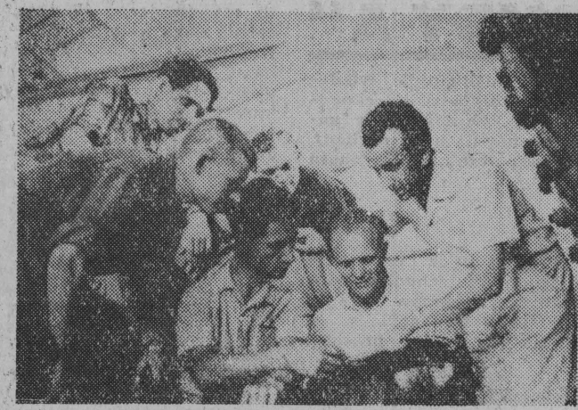
W Penzie hudeł się Zakład Komórkowego Betonu. Wiele maszyn i agregatów dla zakładów wykonano w Polsce. Przy instalowaniu urządzeń pracują również polscy inżynierowie. NA ZDJĘCIU: radzieccy elektrycy i dwaj polscy inżynierowie, oglądają schemat maszyny instalowanej na terenie fabryki. Fot. — CAF
