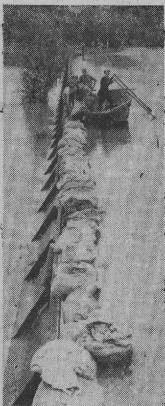
NA ZDJĘCIU: wzmacnianie i podnoszenie zapory na Odrze. Przy pracy straż pożarna oraz robotnicy z Cementowni „Odra” i „Piast”. CAF — fot. Okoński
