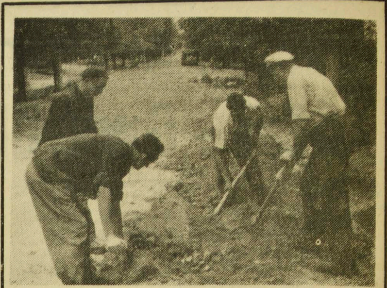
NA ZDJĘCIU: robotnicy wyrównują ziemię na alejce.
