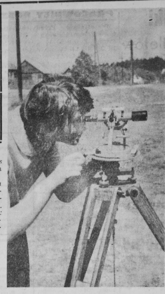
Uczniowie klas II Technikum Geodezyjnego w Białymstoku odbywają miesięczne praktyki zawodowe. NA ZDJĘCIU: jedna z uczennic przy teodolicie. Fot. Wel
