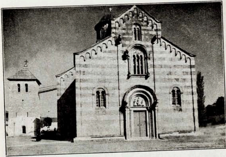
Visoki Dečani, fasada cerkwi
