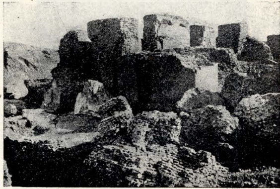
Ryc. 264. Babilon, el-Ḳaşr, pilastry głównego (środkowego) pałacu
