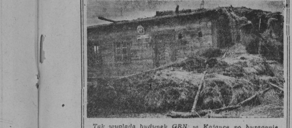
Tak wygląda budynek GRN w Kajance po huraganie.
