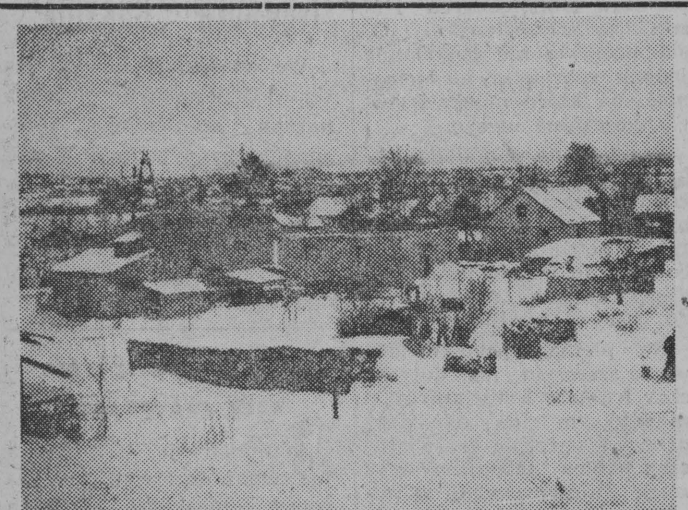
Całe lato i jesień czynne tu było prawdziwe zagłębie budowlane. Przyszli mieszkańcy osiedla produkowali sami wiele zastępczych materiałów budowlanych.
