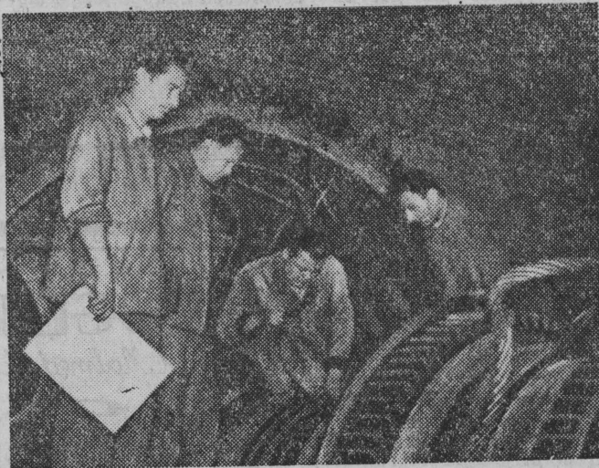
Przy montażu urządzeń walcowni w Hucie im. Lenina pomagają fachowcom polskim inżynierowie radzieccy. Ich doświadczenie i wszechstronna wiedza pozwalają na szybszy i sprawniejszy montaż urządzeń.
