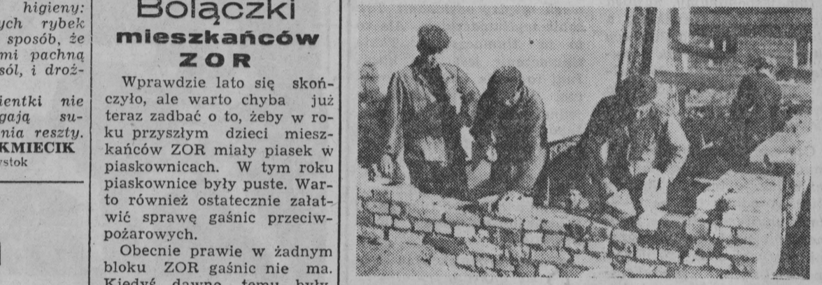
NA ZDJĘCIU: obok kotłowni buduje się również bункier na pomieszczenia węgla. Pracy jego budowie pracuje brygada Gryczana.
