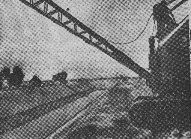
Prace przy budowie kanału na Kuwasach.
