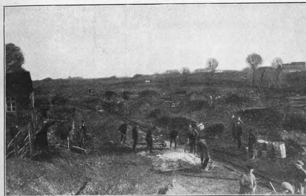
Fot. 3. Radom. Budowa rzeźni. (str. 131).
