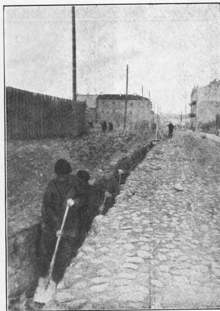
Fot. 1. Kanalizacja Radomia. Piaski, bocznicą 47. (str. 127).
