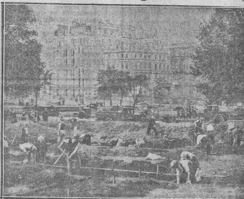
W Londynie rozpoczęto budowę schronu nowo-przeciwgazowego w całym mieście. Na zdjęciu budowa schronów w Hyde Parku.
