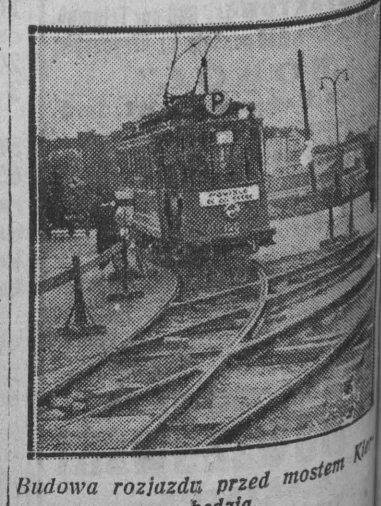
Budowa rozjazdu przed mostem Kierbedzia.
