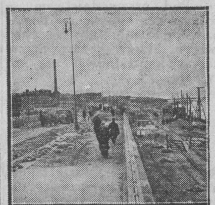
...już rozpoczęto prace przy asfaltowaniu Bulwaru Gdańskiego.
