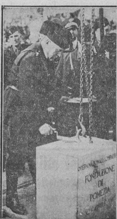
Mussolini w rocznicę urodzin wynalaz- cy radia W. Marconiego (25 bm.) kła- dzie kamień węgielny pod budowę no- wego miasta Pomezia. Miasto to będzie piątym z kolei, powstałym na teryto- rium, które pokrywały do niedawna sławne błota Pontyjskie
