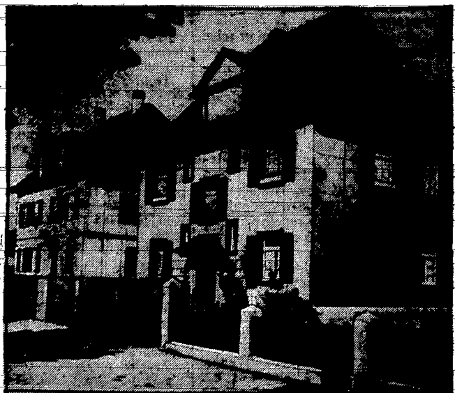
Budowa domów ze stali zdobywa coraz to szersze zastosowanie. Na zdjęciu grupa takich domów w Monachium.
