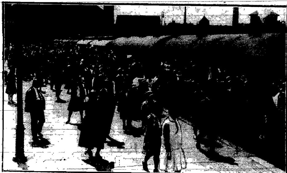
Szczęśliwi ten, kto może w słoneczne i upalne lato opuścić mury miasta i przenieść się tam, gdzie królują słońce, woda i zieleń. Oto grupa radosnych „uciekierów”.
