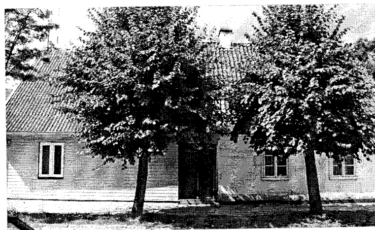
Ilustracja 14. Przykład modernizacji dawnego domu tkacza, obecnie domu mieszkalnego, przy ul. Cieliczańskiej 20 w Supraślu. Lewa połowa elewacji frontowej oszalowana jest sidingiem , na prawej widoczna jest oryginalna konstrukcja wieńcowa bielona wapnem. Pół dachu pokryto eternitem, a pół – dachówką ceramiczną. Różnicowanie wynika zapewne z faktu, iż obie połowy budynku mają różnych właścicieli. Fot. autor.
