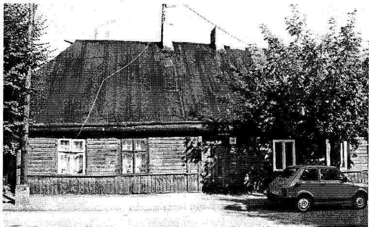
Ilustracja 7. Elewacja frontowa dawnego domu tkacza przy ul. Łęczyckiej 18 w Zgierzu (obecnie budynek mieszkalny). Fot. autor.
