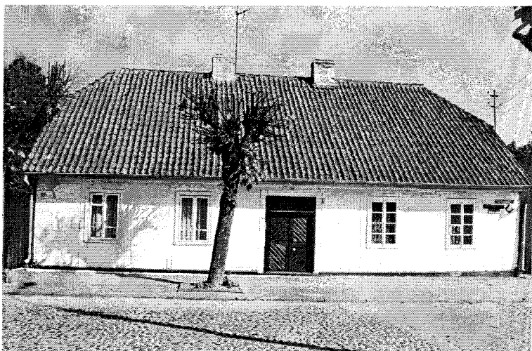
Ilustracja 8. Elewacja frontowa dawnego domu tkacza przy ul. 3 Maja 18 w Supraślu (obecnie budynek mieszkalny). Fot. autor.
