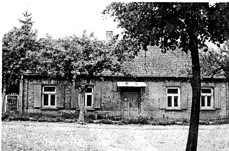
Ilustracja 9. Elewacja frontowa budynku mieszkalnego z końca XIX w. przy ul. 11 Listopada 32 w Supraślu (stan obecny). Fot. autor.
