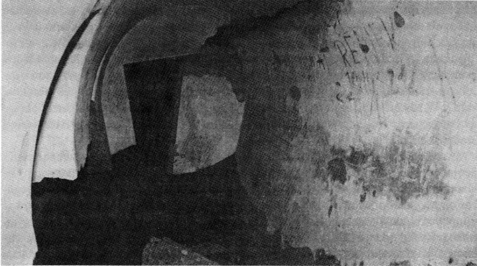
Wnętrze koszar Fortu Nowego
