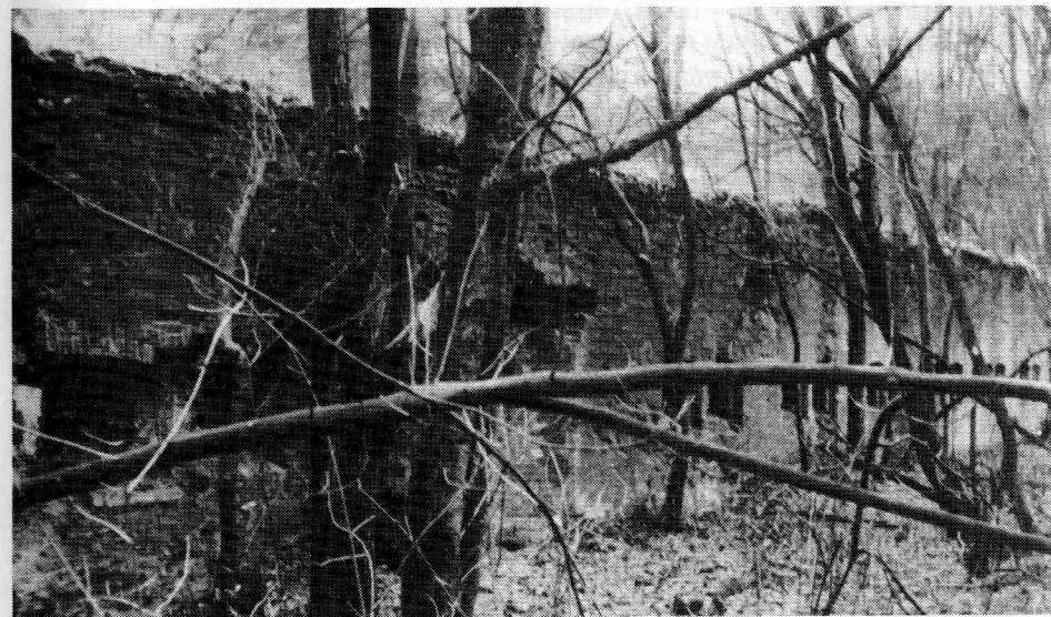
Mur Carnota w rowie Fortu I
