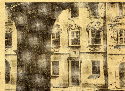
W Opolu w szybkim tempie są odbudowywane i rekonstruowane stare zabytkowe kamieniczki.
