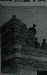
NA ZDJĘCIU: przy budowie domu mieszkalnego w Staśku Handolowi Rolin w Piszczycy...
