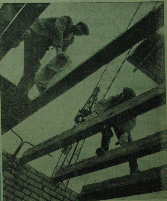
Na budowie Foi. Kwiatkowski
