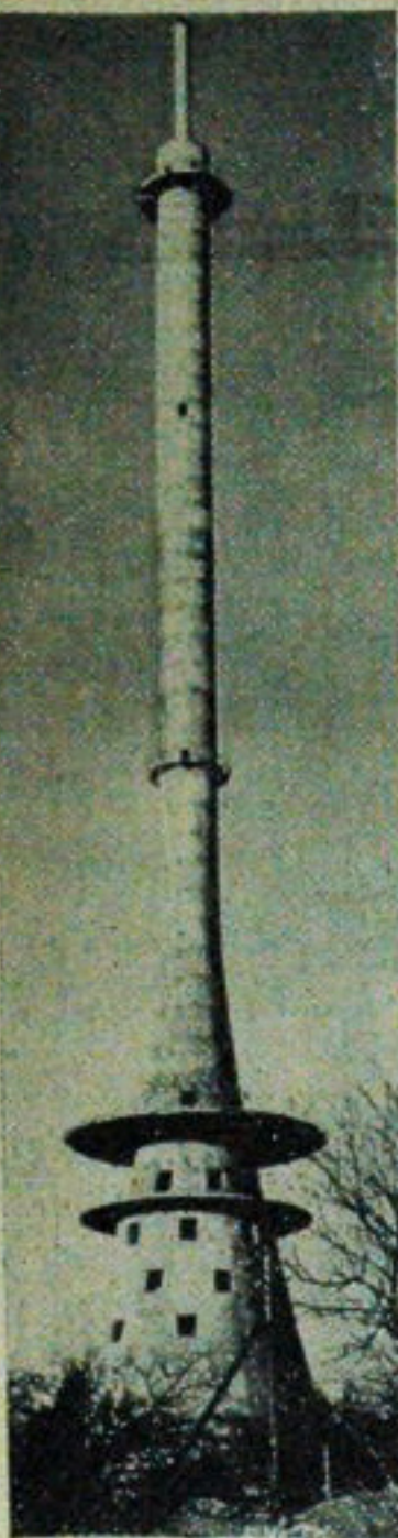
W połowie bieżącego roku rozpocznie pracę telewizyjna wieża nadawcza budowana obecnie na Sw. Krzyżu. Ma ona 122 metry wysokości. Koszt budowy wyniesie około 45 mln zł.
