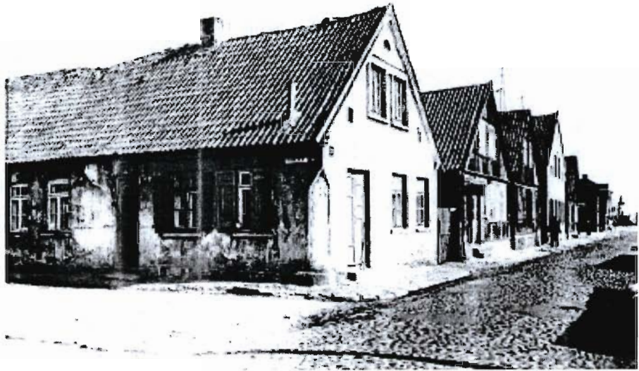
Il. 4. Ulica Młynowa, pierzeja południowa, widok od skrzyżowania z ul. Odeskiej w kierunku centrum miasta. Na ostatnim planie widoczna jest wieża Ratusza. Ulica Młynowa jest częścią historycznej osi widokowej, dawnego traktu. Do ilustracji wykorzystano fotografię A. Stasiaka, wykonaną w 1978r. Neg. PKZ nr 137728.
