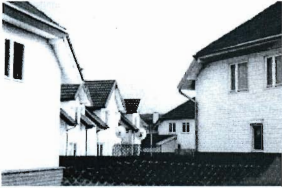
Fot. 3. Osiedle „Dom Twoich marzeń” w Fastach, gmina Dobrzyniewo Duże. Zabudowa jednorodzinna średniointensywna, z przewagą szeregową na niewielkich działkach
