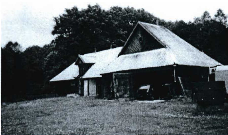
Fot. 4. Budynki gospodarcze osady leśnej w Przewalance z lat dwudziestych XX wieku. W chwili obecnej dostosowane przez użytkowników do bieżących potrzeb - warsztat i garaż na samochody osobowe
