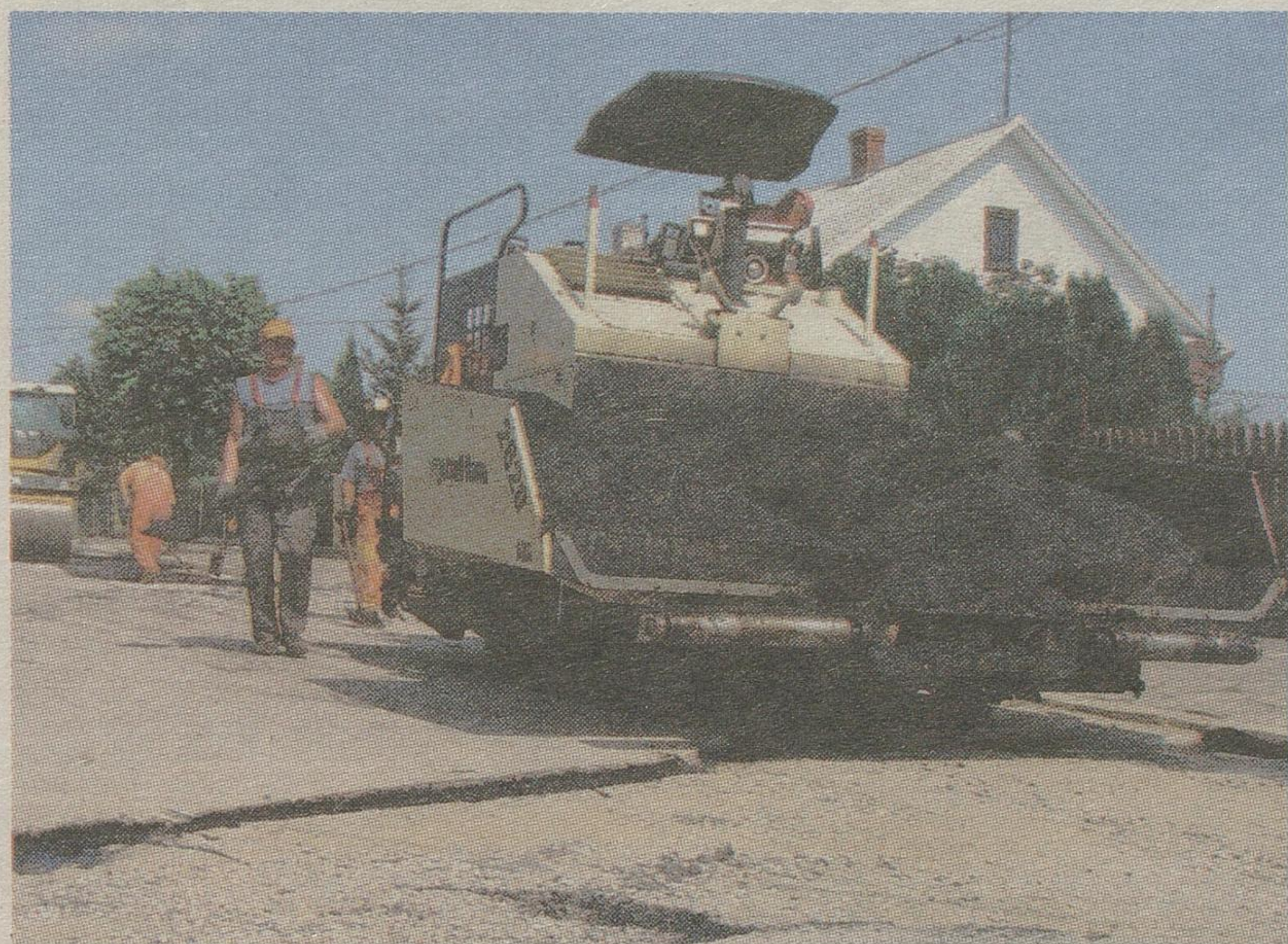
W Orli trwa odbudowa nawierzchni po budowie kanalizacji sanitarnej w kilku ulicach, m.in. Adama Mickiewicza
