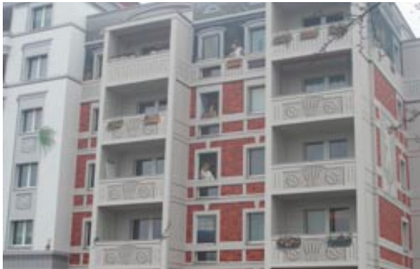
Ryc. 10. Iluzoryczny obraz namalowany na płaskiej elewacji budynku wykonanego z wielkiej płyty po wykonaniu termoizolacji budynku. Budynek u zbiegu ulic Stendalerstrasse i Arneburgerstrasse w Berlinie, fot. autor
