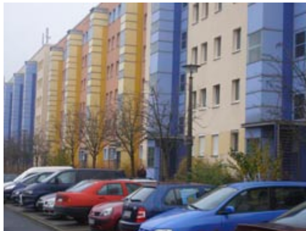
Ryc. 8. Na ilustracji widoczne są instalowane windy zewnętrzne w modernizowanych budynkach przy Stendalerstrasse. Przykład z modernizowanego osiedla Hellersdorf w Berlinie, fot. autor
