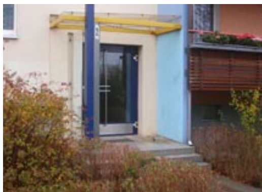
Ryc. 5. Fotografia przedstawia przeprowadzone już prace budowlane związane z nowym ukształtowaniem wejścia do klatki schodowej budynku przy Stendalerstrasse na osiedlu Hellersdorf w Berlinie, fot. autor
