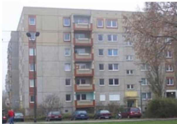
Ryc. 1. Przykład typowego budynku wielorodzinnego występującego na osiedlu Hellersdorf w Berlinie, fot. autor
