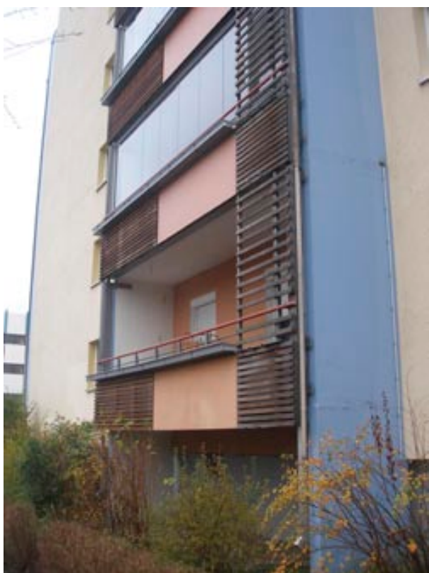
Ryc. 7. Przy modernizacji zadbano również o nowe ukształtowanie balkonów, często zwiększając ich powierzchnię użytkową. W wybranych mieszkaniach zastały one dodatkowo przeszklone. Budynek przy Stendalerstrasse na osiedlu Hellersdorf w Berlinie, fot. autor
