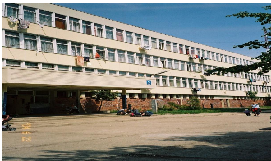
Ryc. 4. Budynek hotelu robotniczego adaptowany na mieszkania socjalne
