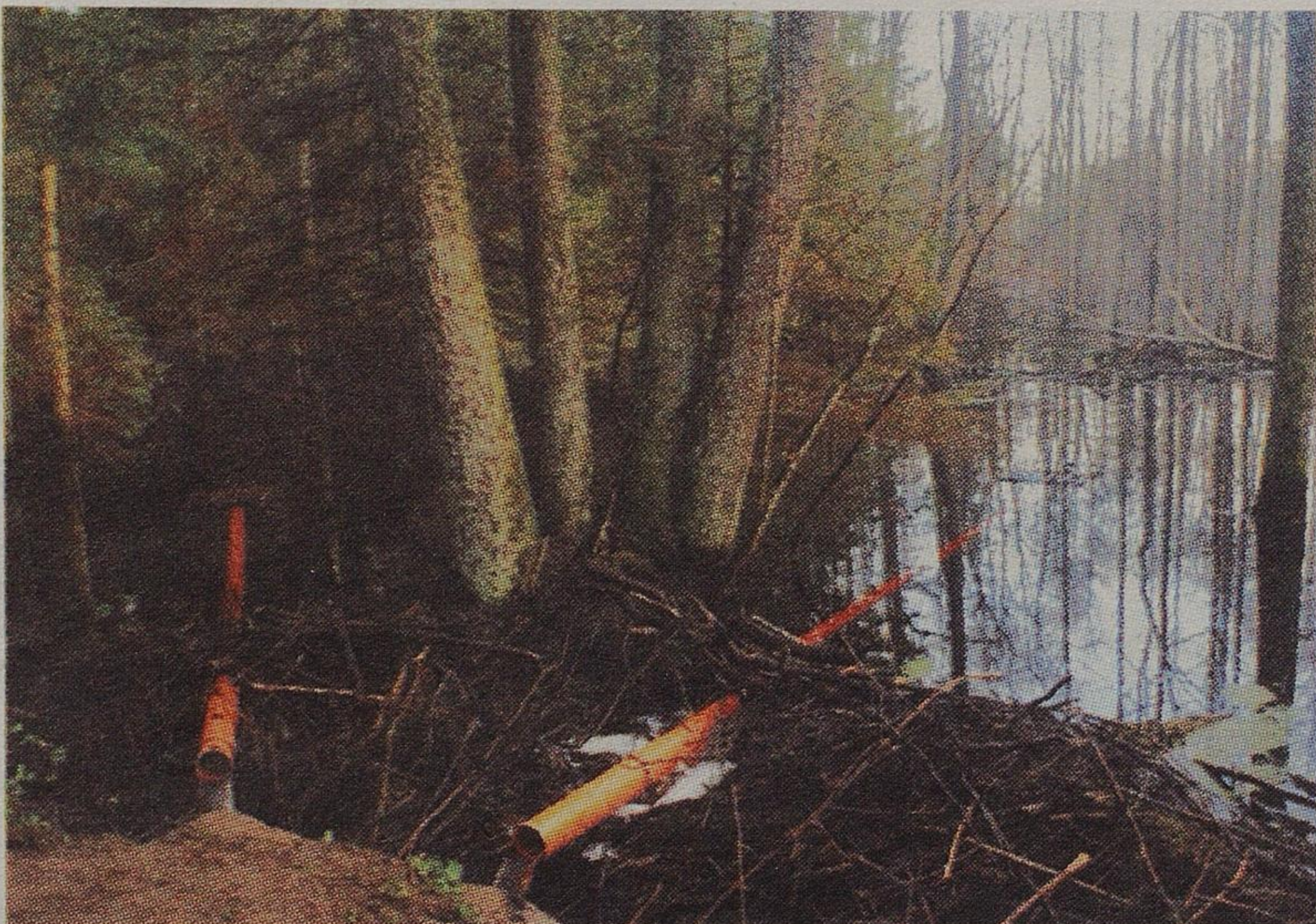
Rury zamontowano m.in. w leśnictwie Polanki, gdzie poprzez podtopienia zagrożony był odcinek drogi
