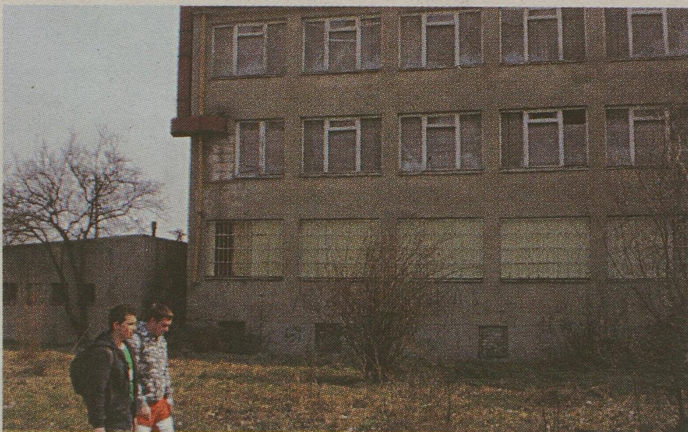
Elewacja budynku jest brudna, a szyby powybijane
