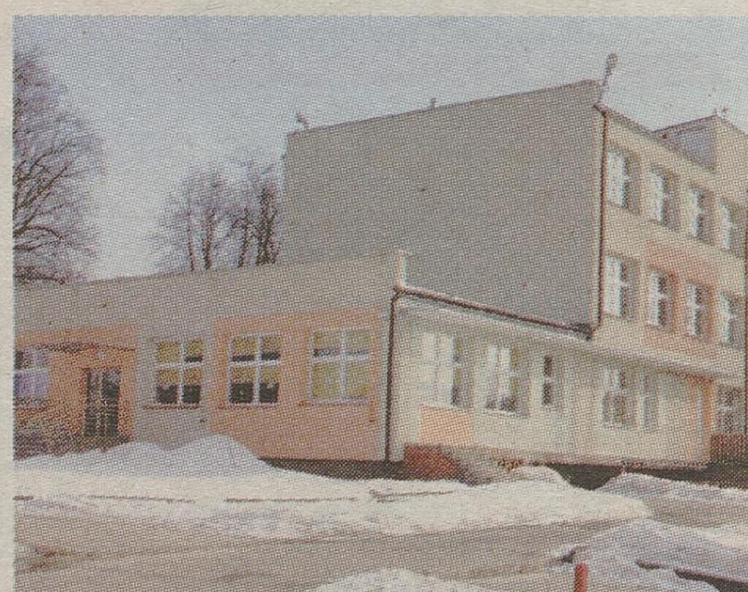
W latach 2003-06 przeprowadzono modernizację budynku szkoły podstawowej przy ulicy Polnej: docieplenie i modernizacja instalacji ciepłowniczej
