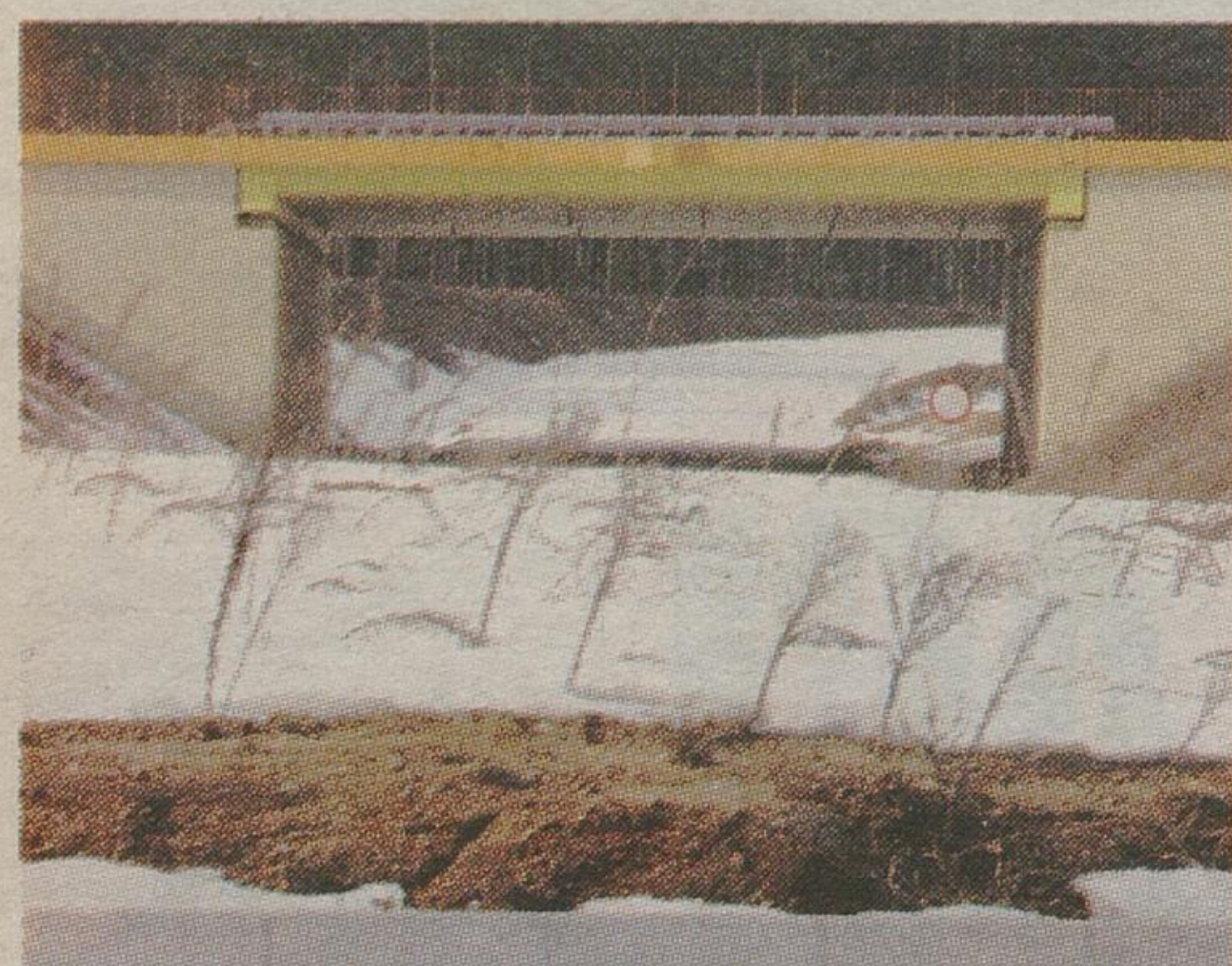
Obwodnica Wasilkowa. Do tej pory powstał już m.in. wiadukt kolejowy nad torami do Sokółki oraz dwa inne wiadukty (ale bez nawierzchni bitumicznej).
