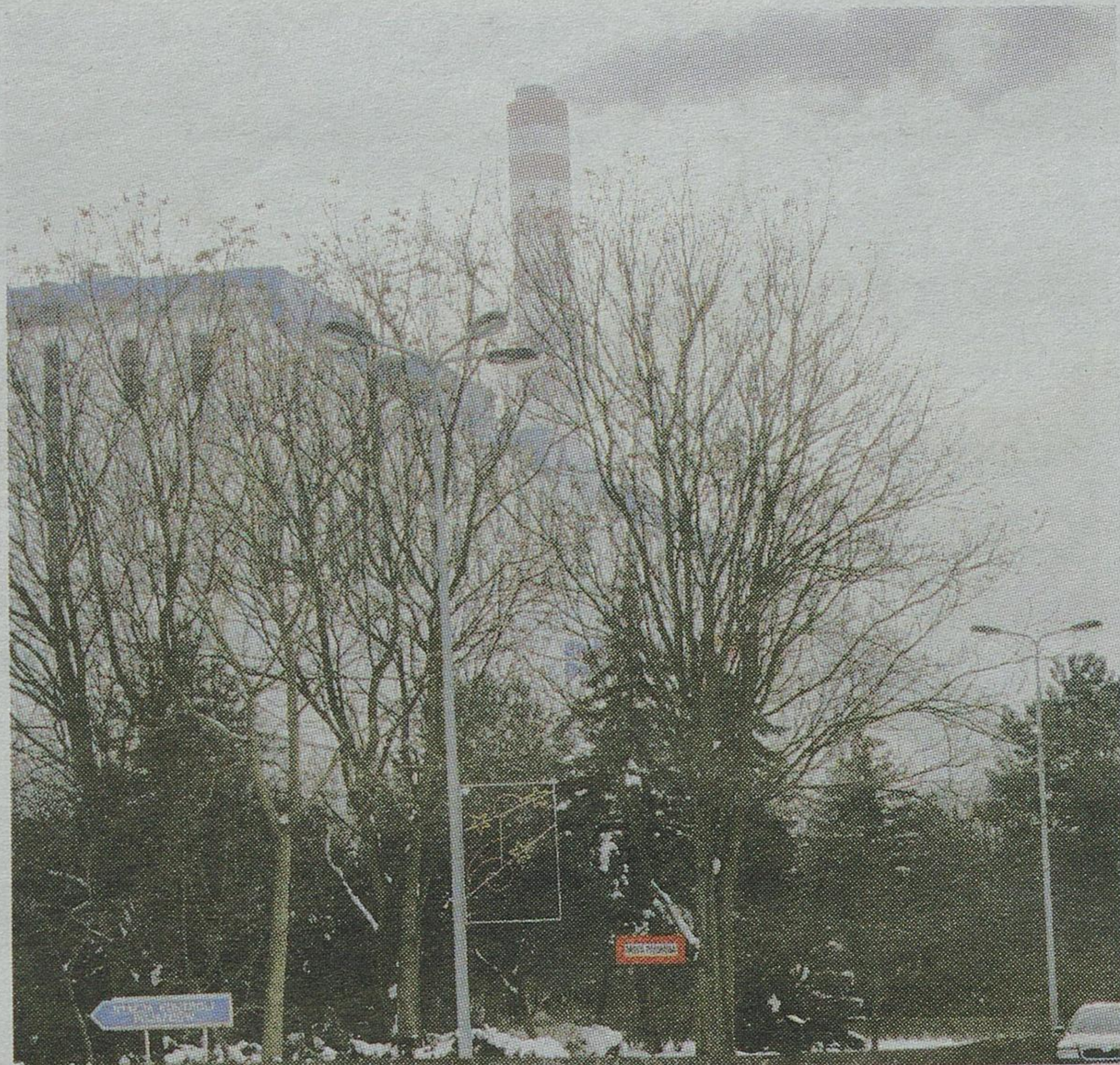
Elektrownia w Nowym Czarnowie powstała w latach 70.
