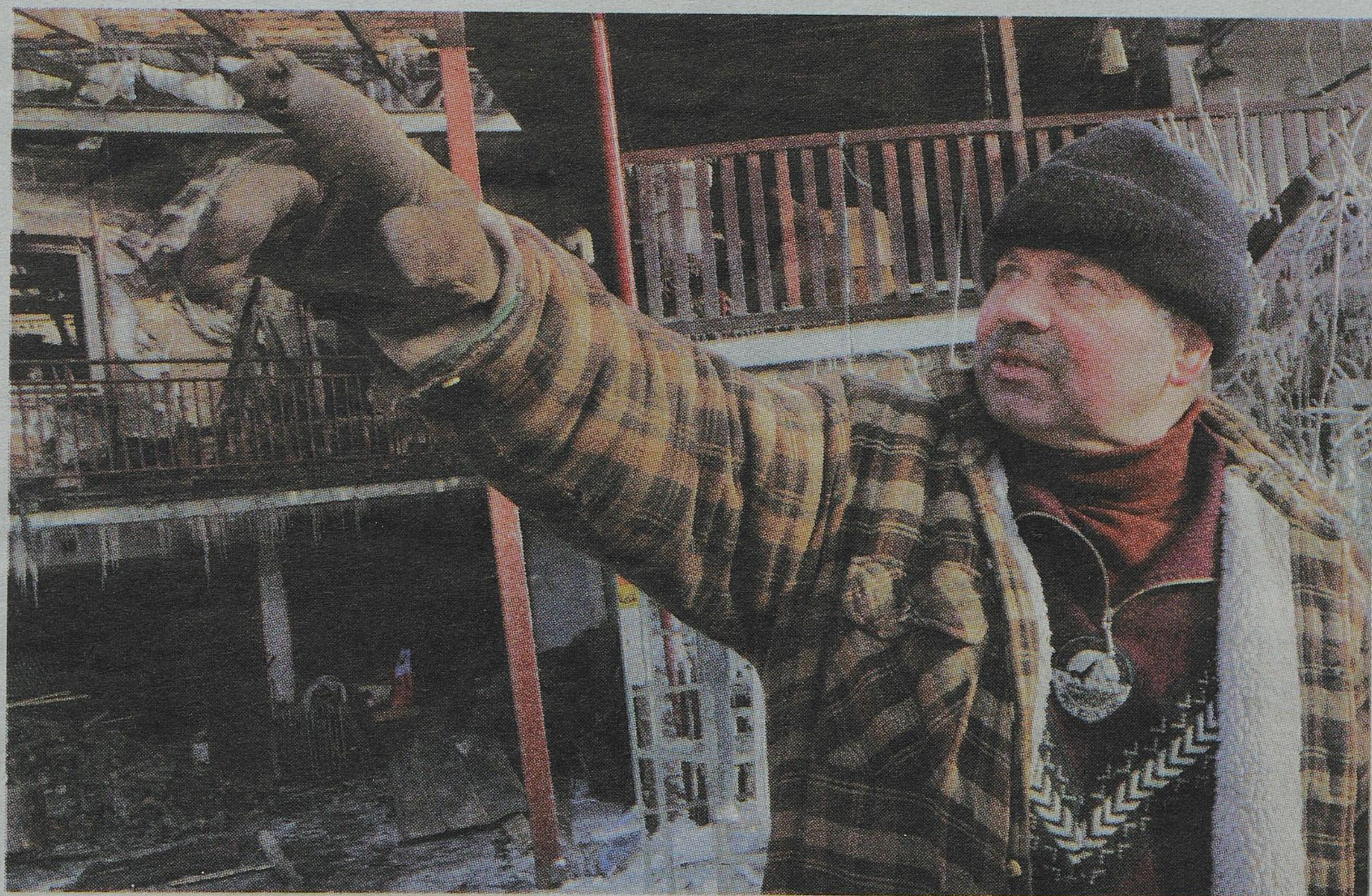
Na dom pan Józef zarobił 20 lat temu na Florydzie. Każdy kamień kładł tutaj on sam, albo ktoś z rodziny. Trzy miesiące temu wymienili dach, komin i rynnę na nowe... Zostały zgłiszcza.
