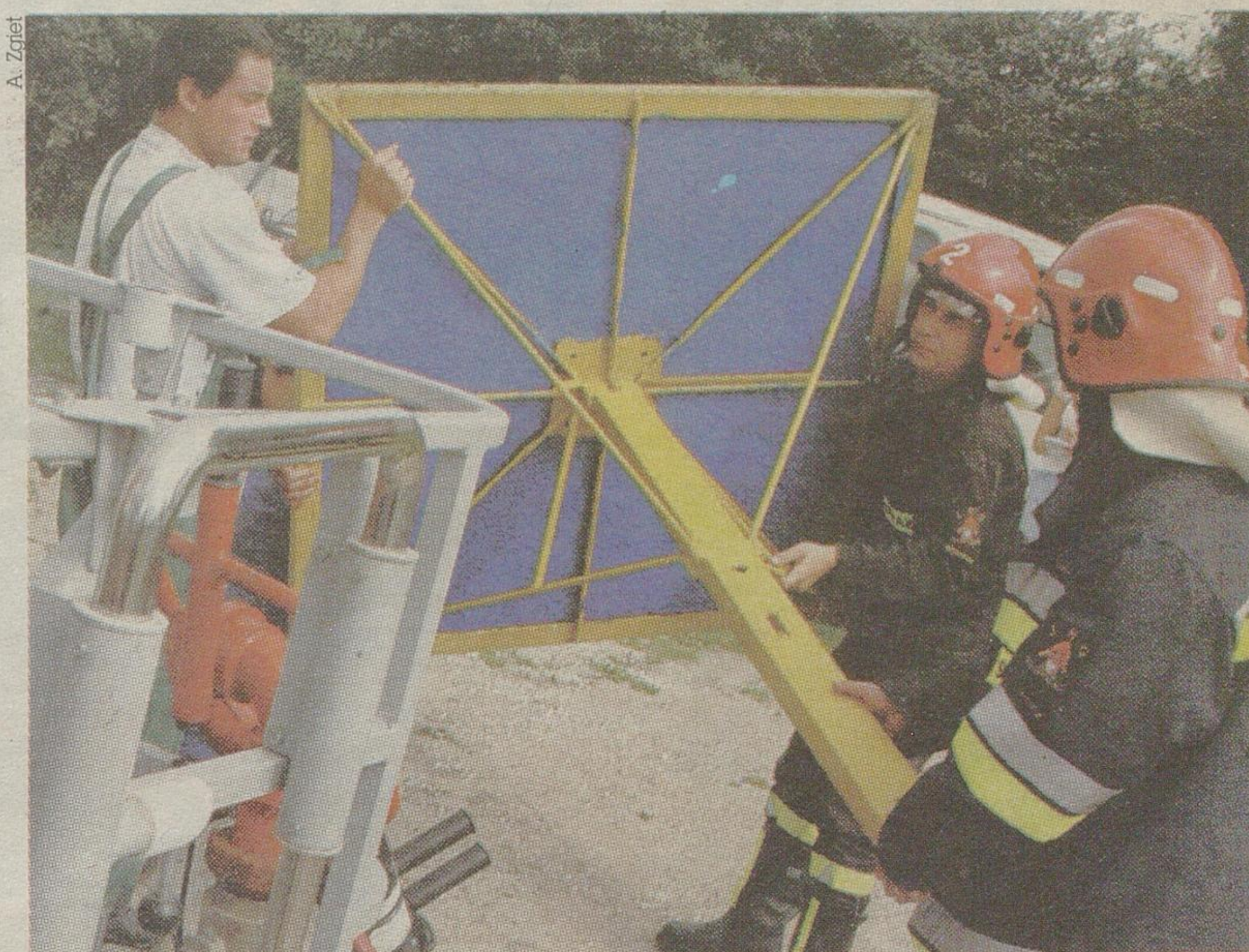
Montowanie platformy z gniazdem bocianim trwa kilka godzin, wymaga użycia specjalistycznego sprzętu
