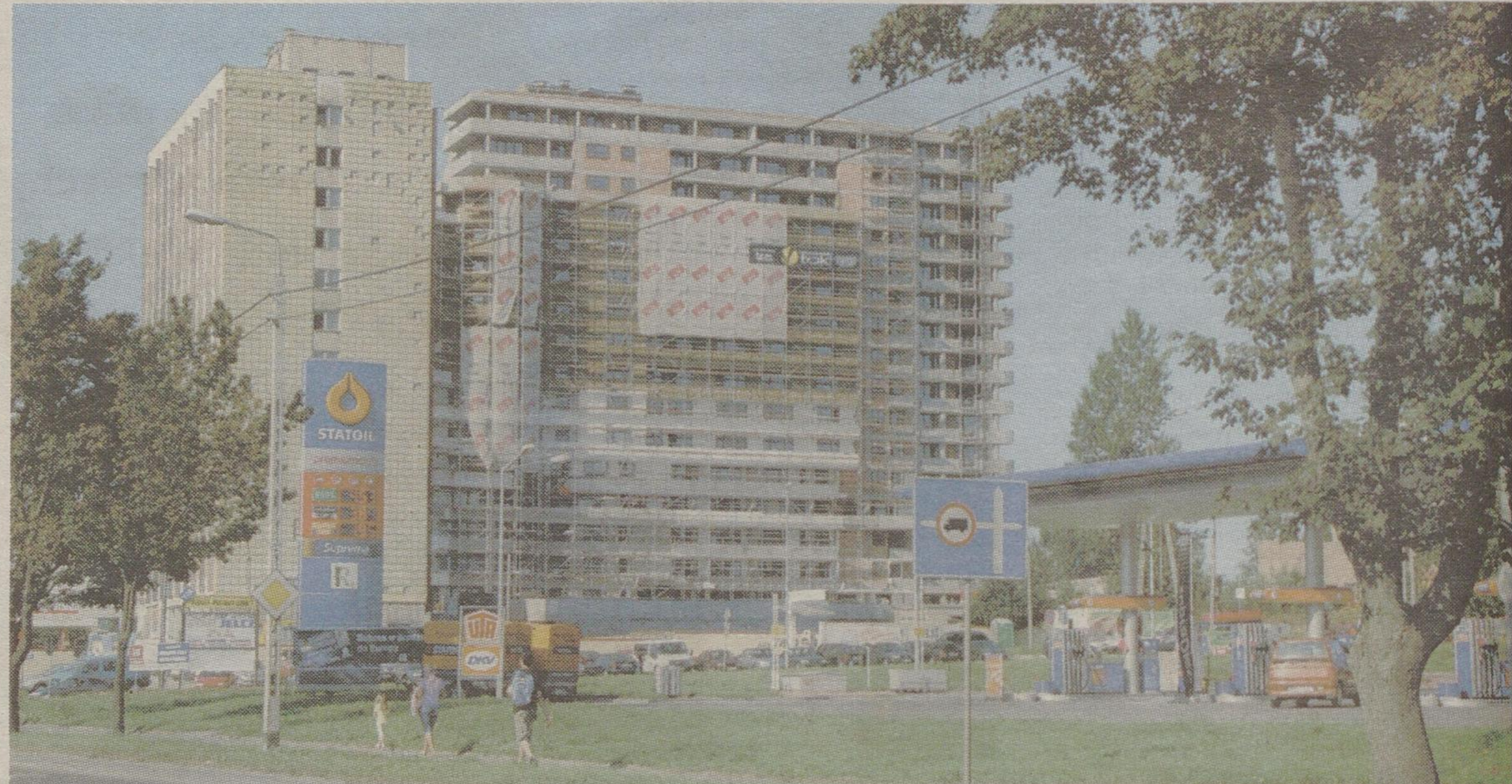
Po zakończeniu budowy budynku nr 1 przyjdzie pora na przebudowę dawnego hotelu robotniczego (z lewej) i budowę kolejnego apartamentowca
