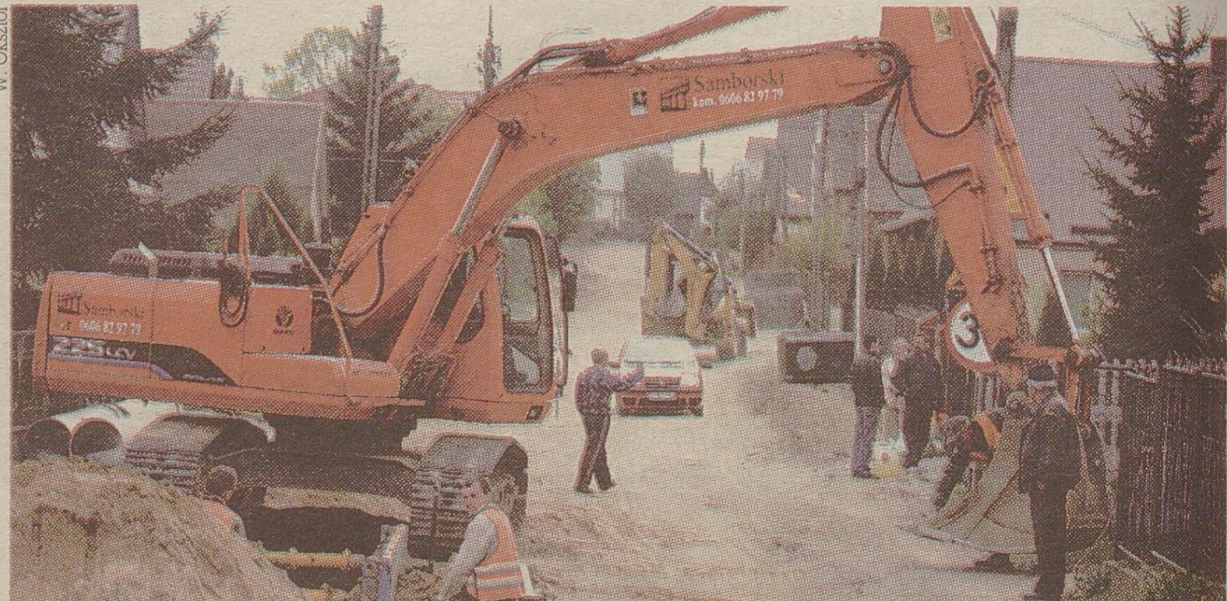
Prace drogowe na Dojlidach trwają już od marca
