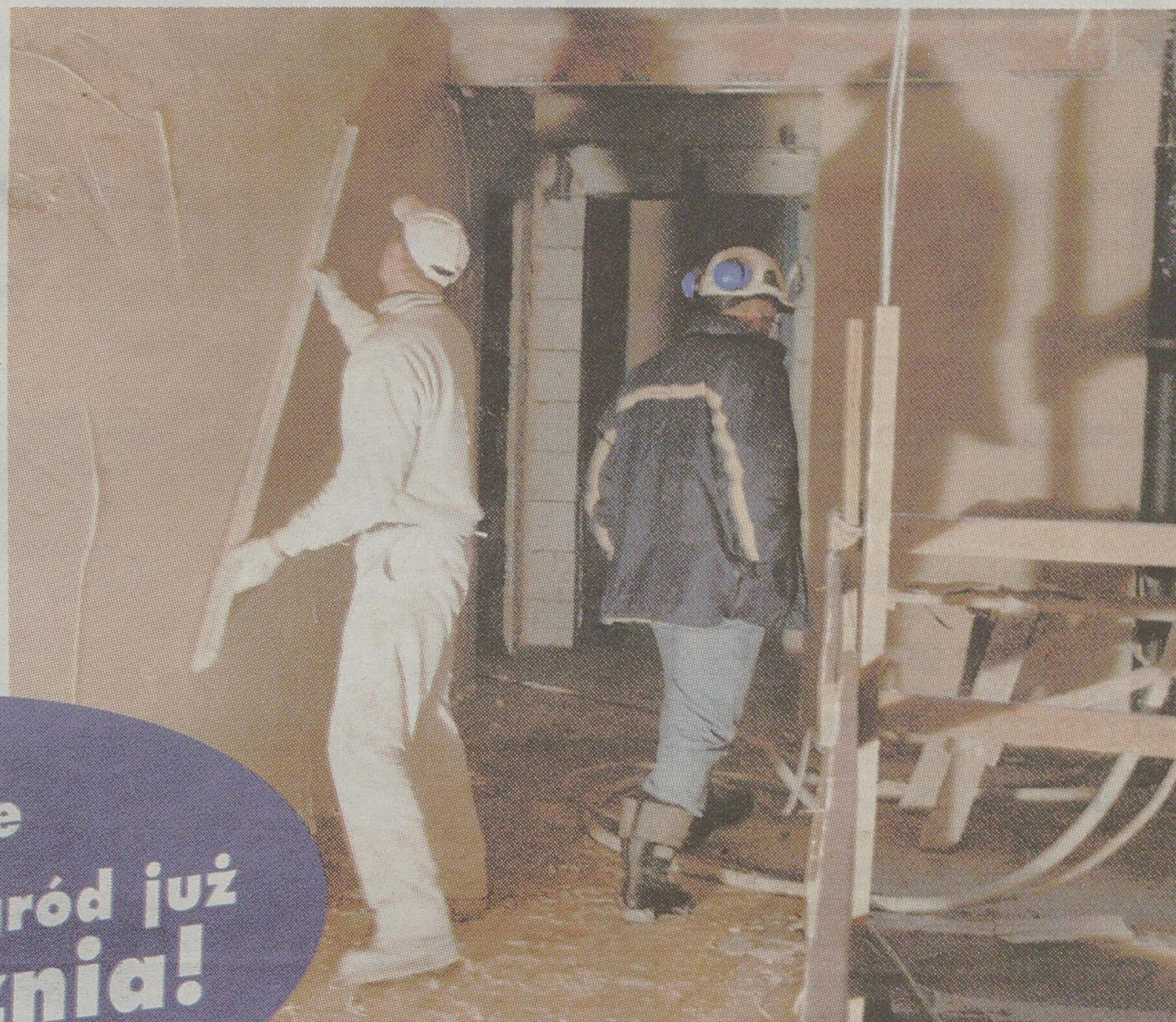
Wnętrze mieszkania konkursowego jest już otynkowane, trwają prace nad klatkami schodowymi
