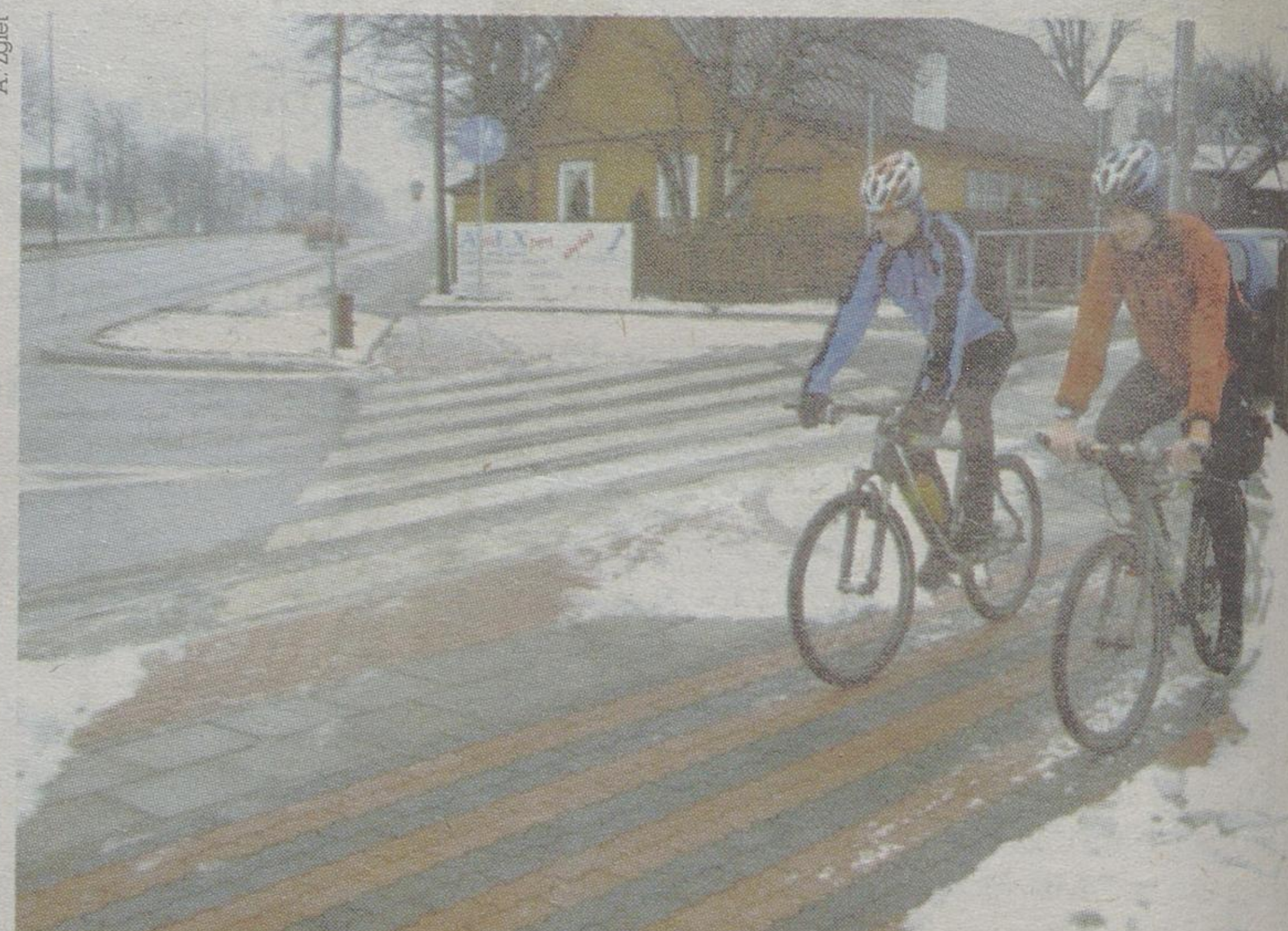
Karol Mocniak i Konrad Oksimowicz przejeżdżają przez fatalne przejście przy skrzyżowaniu ul. Kopernika i Celowniczej
