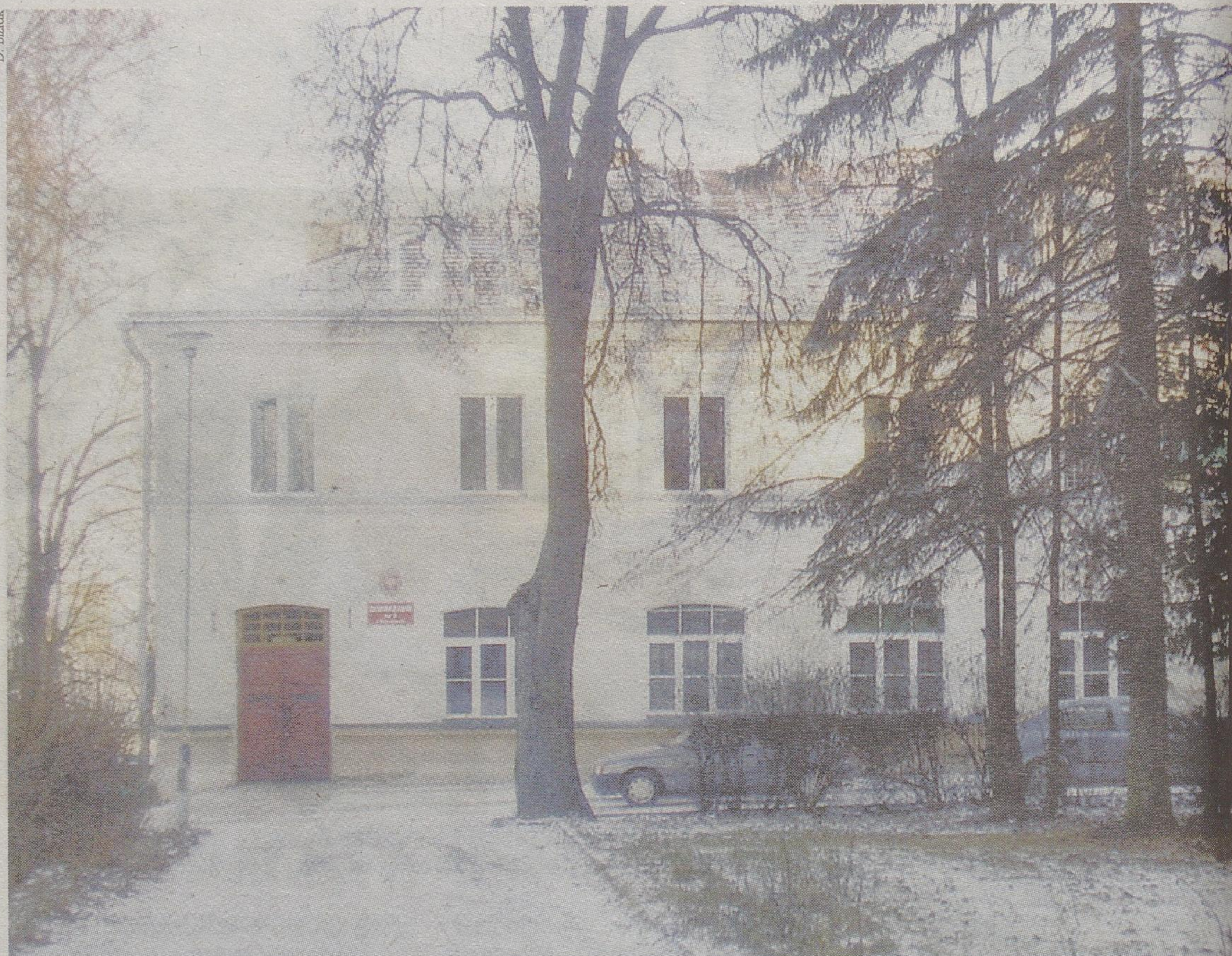
Gimnazjum w Różanymstoku mieści się w XIX-wiecznym budynku. Obiekt wymaga remontu. Władze dąbrowskiej gminy planują zamknąć tę placówkę, a jej uczniów i nauczycieli przenieść do Dąbrowy.
