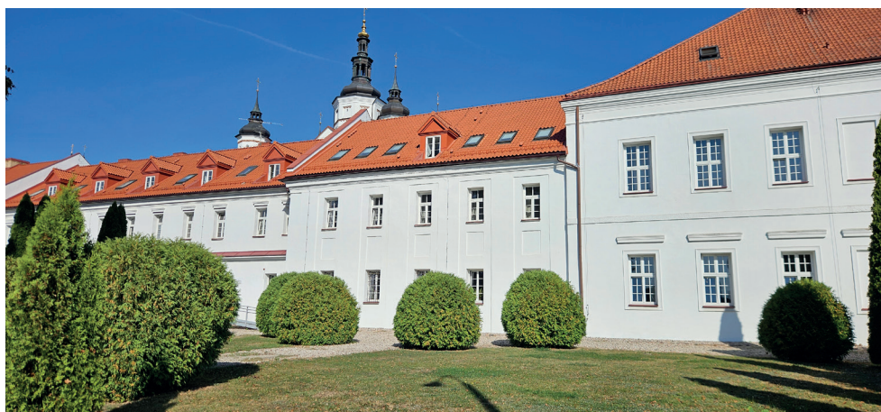
2. Kompleks budynków klasztornych z XVIII w. w Supraślu. Fot. archiwum Podlaskiego Wojewódzkiego Konserwatora Zabytków [dalej: PWKZ]
