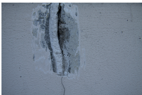
4 d. Miejsce wykonania odkrywki nr 3. Zbliżenie. Pod warstwą malatury wtórnej widoczne resztki oryginalnej warstwy malarskiej w kolorze ugowym (żółcień) oraz oryginalny tynk w kolorze szarym Location of test pit no. 3 - close-up. Under the secondary paint layer, remnants of the original paint layer in yellow (ochre) and the original grey plaster are visible
