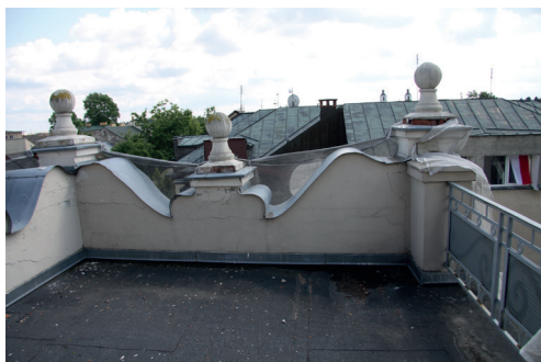
6 a. Miejsce odkrywki naturalnej Location of the natural test pit
