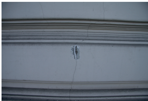
4 b. Miejsce wykonania odkrywki nr 3 Location of test pit no. 3
