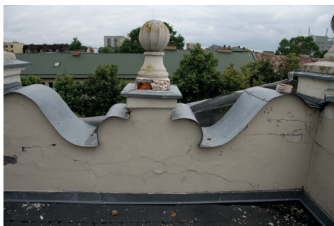
8 b. Miejsce odkrywki naturalnej 7. Zbliżenie Location of natural test pit no. 7 - close-up
