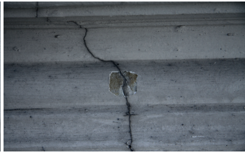
3 d. Odkrywka nr 2. Zbliżenie. Pod warstwą malatury wtórnej widoczne resztki oryginalnej warstwy malarskiej w kolorze ugrowym (żółcień) oraz oryginalny tynk w kolorze szarym Test pit no. 2 - close-up. Under the secondary paint layer, remnants of the original paint layer in yellow (ochre) and the original grey plaster are visible
