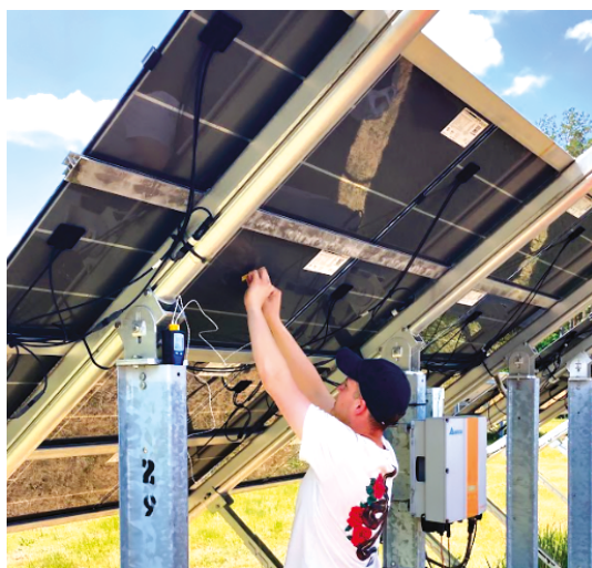
RYS. 5. Montaż czujnika temperatury modułu fotowoltaicznego
