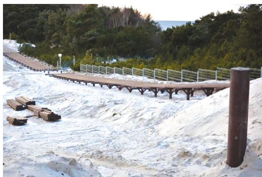
RYS. 4. Budowa trasy rowerowej na kładce posadowionej na palach
