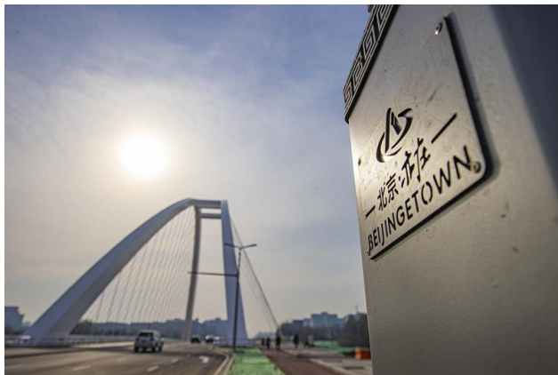
Rys. 10. Wenchang Avenue Bridge nad rzeką Liangshui - przykład smartbridge Źródło: na podstawie http://www.beijingetown.com [20.04.2024].
