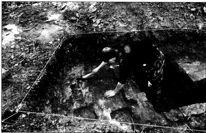
Ryc. 5 – Czerlona. Podczyszczanie odsłoniętych konstrukcji, fot. A. Andrzejewski.
