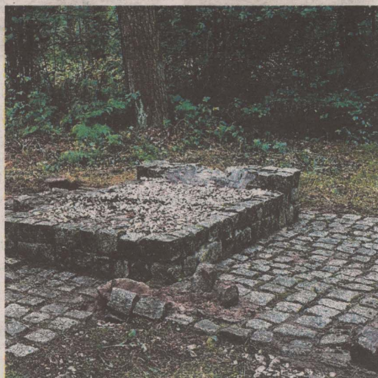
Zniszczenia zastane 29 lipca
