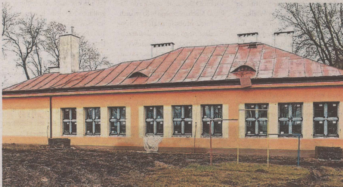
Budynek szkoły w trakcie remontu
