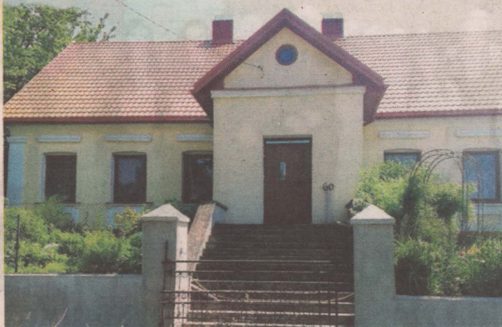
Budynek byłej szkoły z 1892 r., obecnie prywatny
