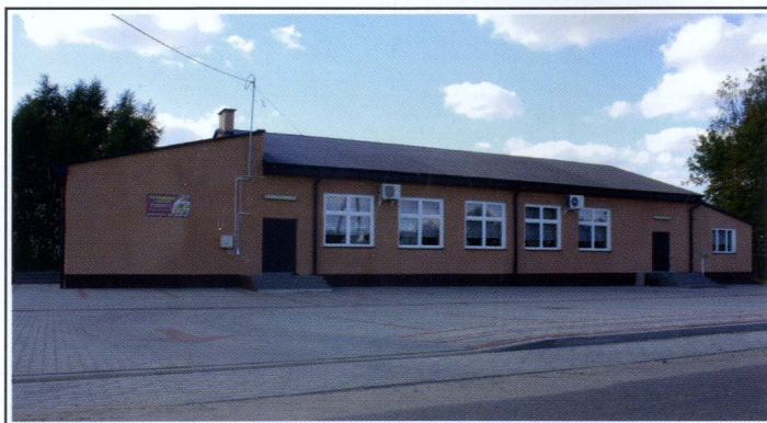
Świetlica w Starym Ratowie
